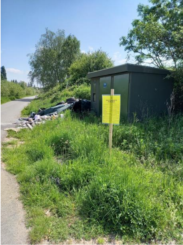
Déchets près du site « crématorium »
